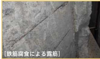
【鉄筋腐食による露筋】
