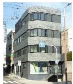
本建物には、補強工事が行われ、ブラソ・内外装・設備が刷新されました。大通りに面した1階の窓は大きくなり、入居する会社のイメージカラーで塗装された耐震補強プレース（模型）が配置された事務所ビルに生まれ変わりました。
